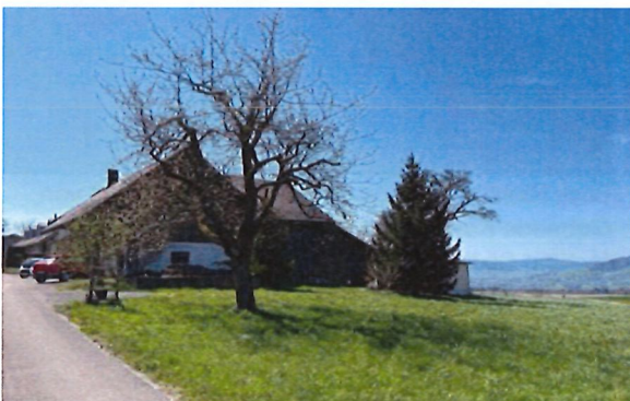
Gebäude Königsberg 4 mit kleinem Nebengebäude 4.2 rechts der Bildmitte, von Norden gesehen. Im Vordergrund Freiraum und Aussichtspunkt 4B/4A.
