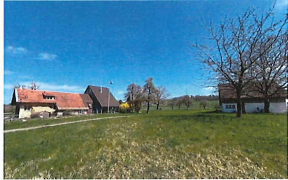
Blick Richtung Nordosten, Gebäude Königsberg 1 (links) und Königsberg 3 (rechts) mit prägendem Baum vor Gebäude 3 und Freiraum 3B im Vordergrund
