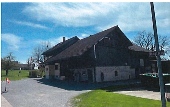
Gebäude Königsberg 2 aus Blickrichtung Südwest
