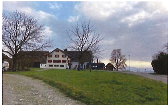
Gebäude Königsberg 10 (mitte), 12 (mitte-links) und 10.1 (linker Bildrand), Blickrichtung Norden. Im Vordergrund Freiraum 3B.
