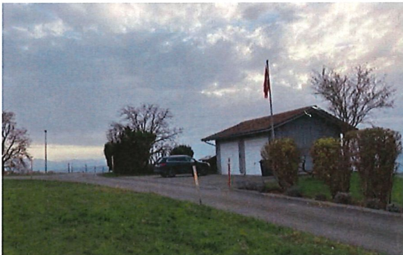
Garagengebäude Königsberg 6.1, 8.1, Blickrichtung Südwesten
