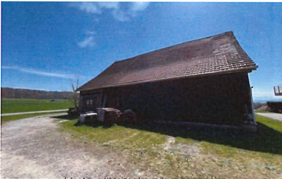
Nebengebäude (Lagergebäude) 10.1, von Norden gesehen
